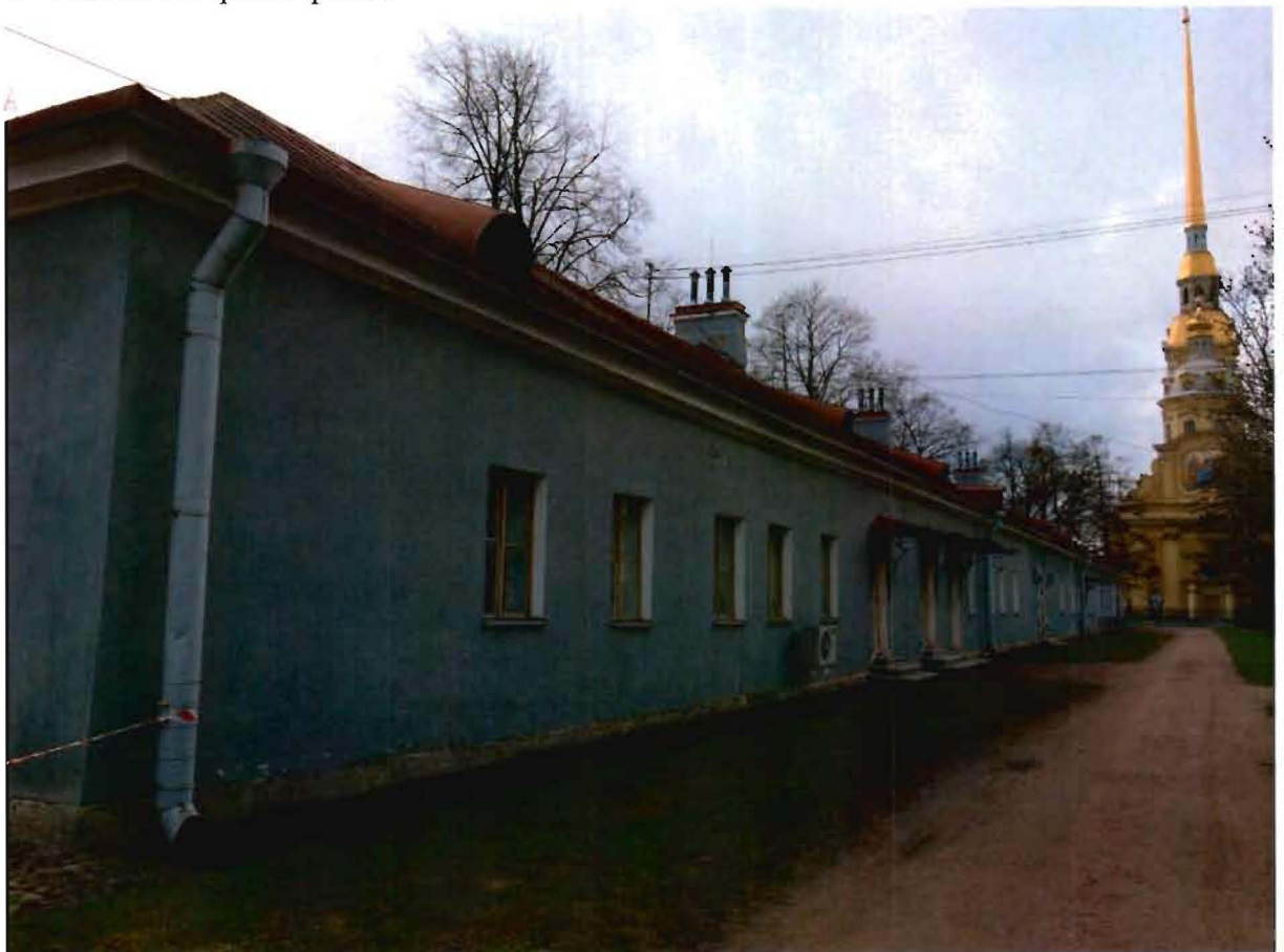
4. Вид на северный фасад.
