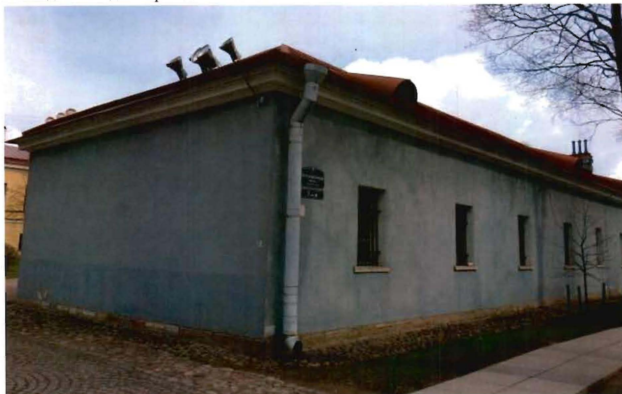
2. Вид на западный фасад.
