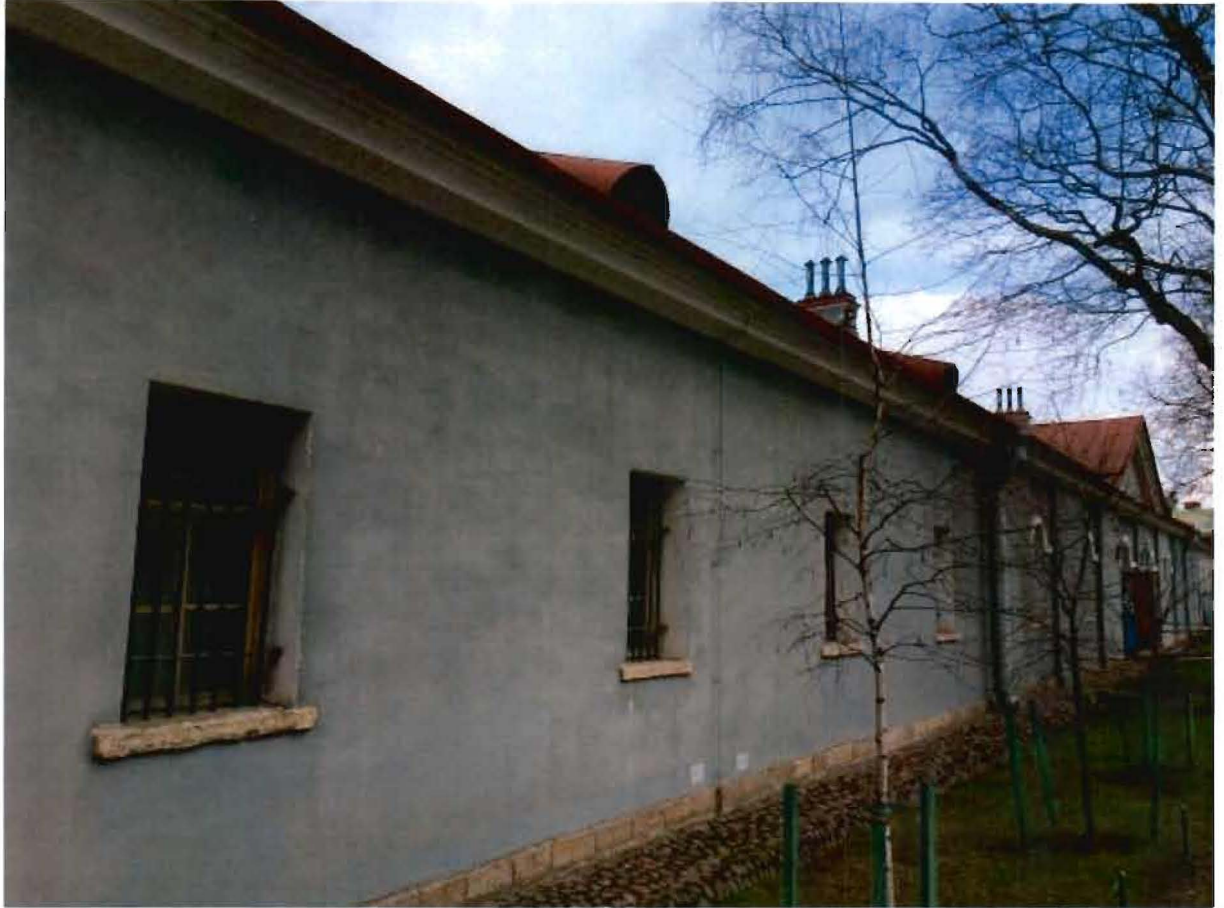
3. Вид на южный фасад.
